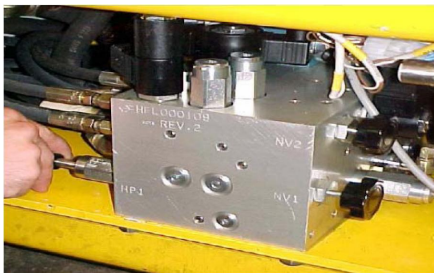
Рисунок 24. Аварийное растормаживание колес подъемника.
